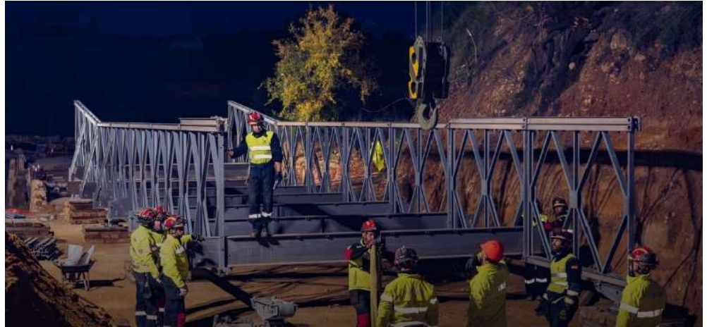
Puente Mabey de la UME. Foto del MINISDEF
