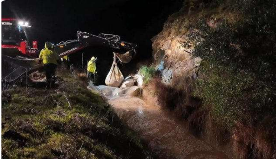
Momento de la intervención de una compañía de ingenieros taponando salidas de agua / UME
