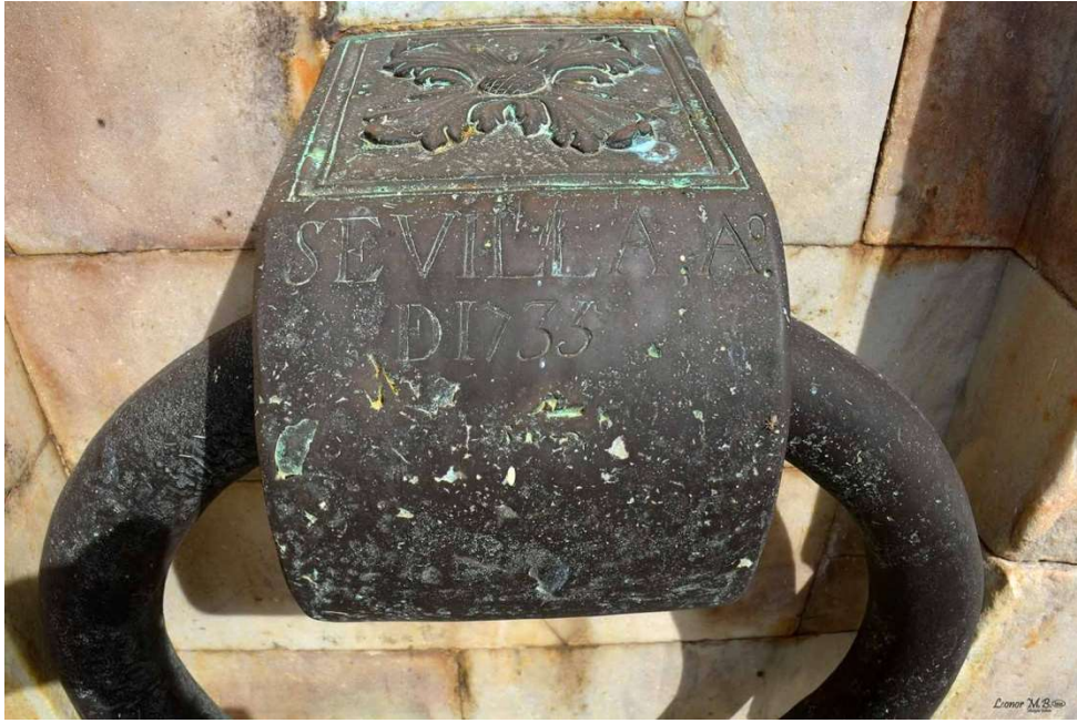
Detalle de las argollas del pórtico
